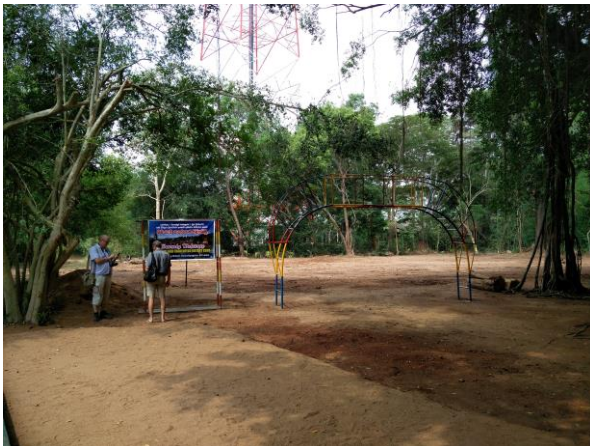
Der für die Tagesschule vorgesehene Platz ist bereits gerodet und planiert
